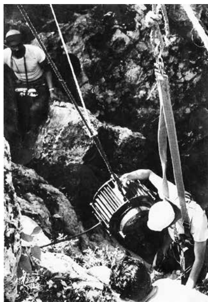
Al momento de ingresar al Pozo Meléndez.
