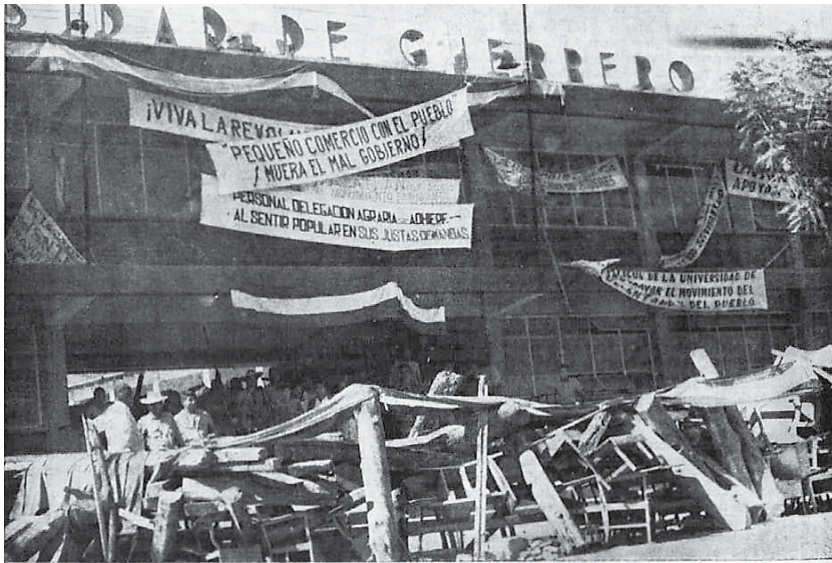
BARRICADAS FRENTE A LA UNIVERSIDAD DEL SUR
